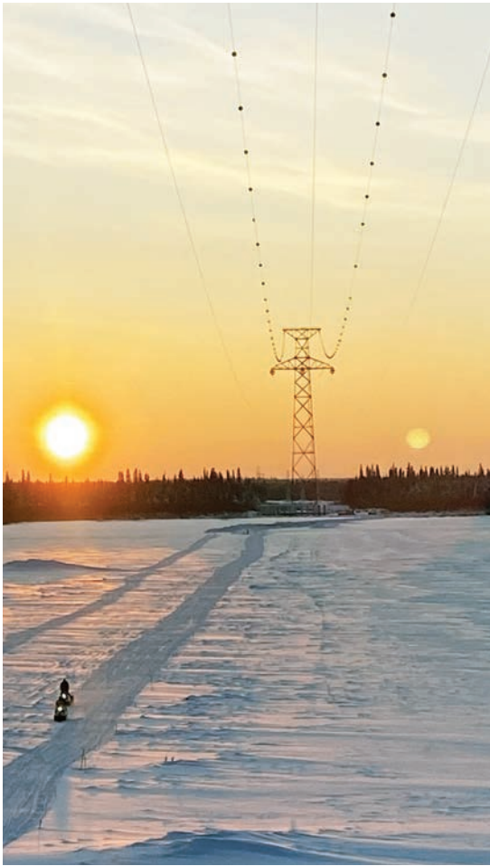
△ Между опорами на двух берегах Печоры – 2,6 километра © ЕЛЕНА КУШТУЕВА
